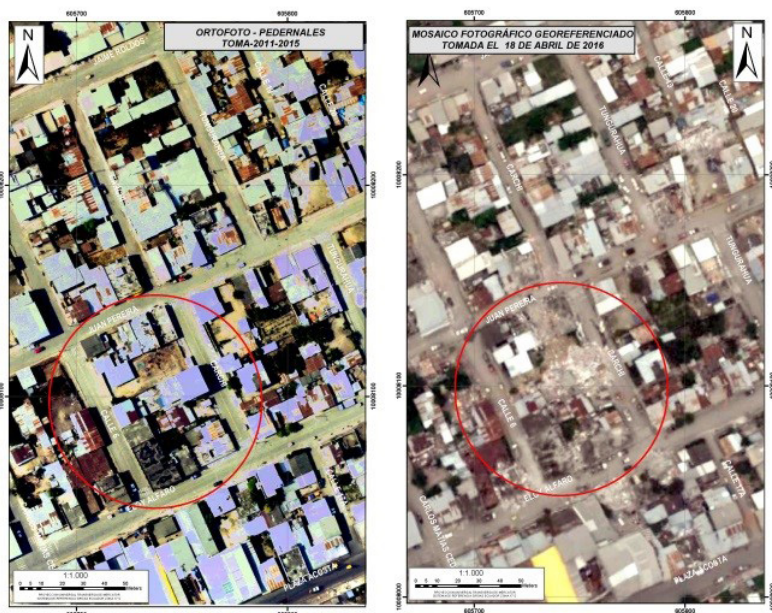
Figura 4. Comparación de edificaciones existentes y destruidas (antes y después del sismo). Estudio cartográfico: IGM Ecuador, 2016.
